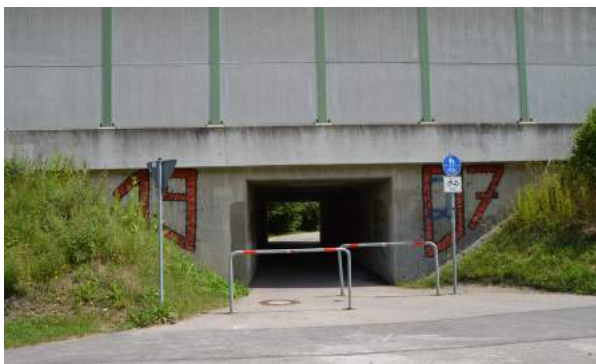
Abb. 107: Bahnunterführung als Angstraum
