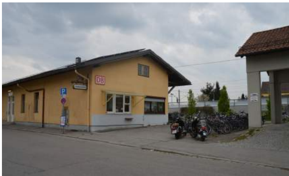
Abb. 106: Mangelnde Aufenthaltsqualität am Bahnhof Mering
