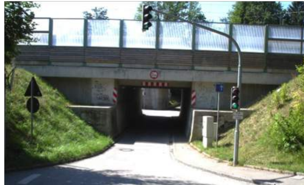
Abb. 38: Schwachpunkte des Wegenetzes in Mering, Zettlerstraße
