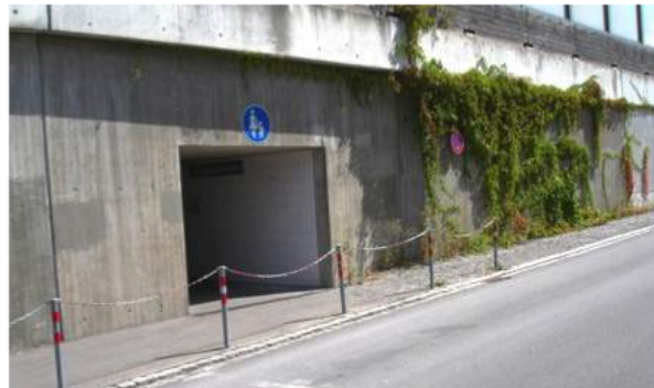
Abb. 40: Schwachpunkte des Wegenetzes in Mering, Entrée zur Altstadt
