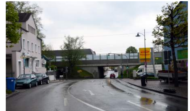
Abb. 112: Bahnunterführung Münchener Straße
