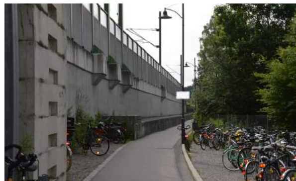
Abb. 110: Zugang zum Bahnhof
